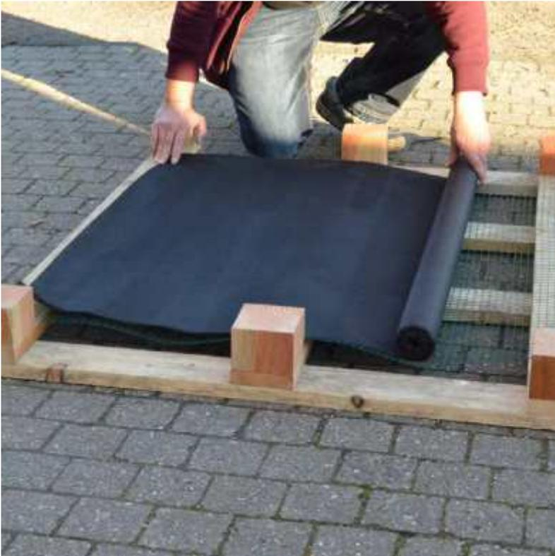
Als nächste Schicht rollen wir ein 1000mm breites Wurzelvlies über dem Hasendraht aus.
