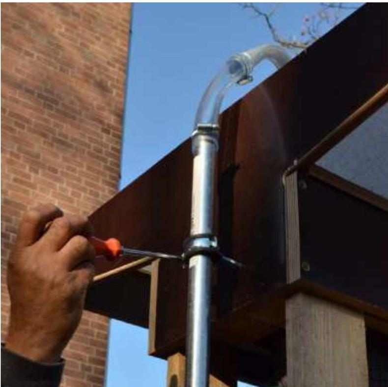
Den unteren PVC-Schlauch stecken wir auf das kurze Rohrstück, das oben aus der Pumpe ragt und befestigen es mit einer Schlauchschelle.
