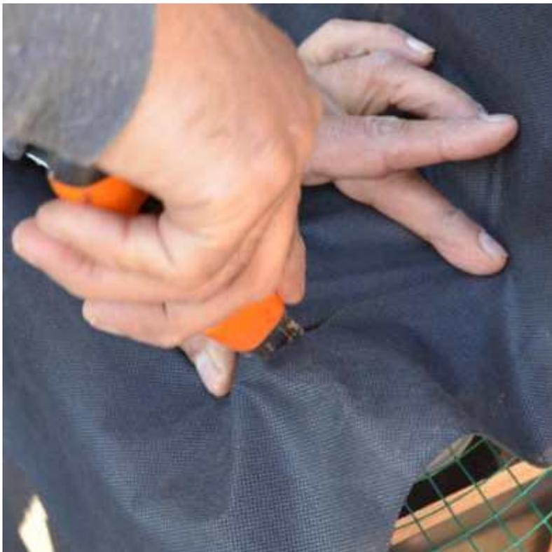
Nun legen wir auch das Wurzelvlies über den Deckel und schneiden es an den Abflussdeckeln mit einem Cuttermesser kreuzweise ein.
