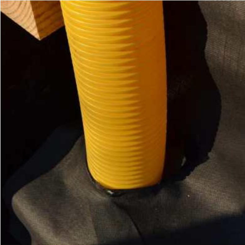
So kann das Drainagerohr ungehindert in den Abflussdeckel gesteckt werden.
