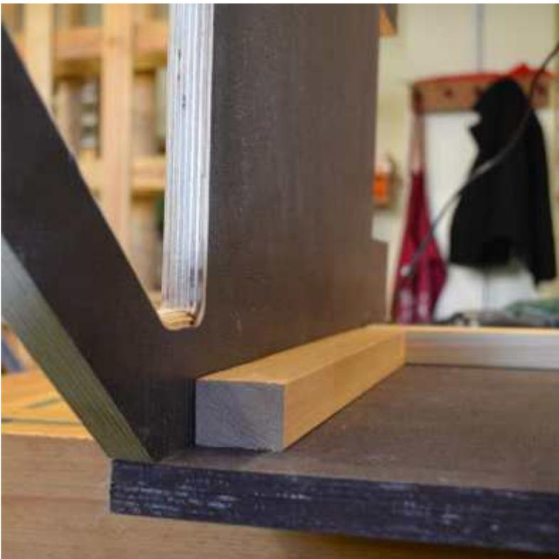
Wenn ihr genau gearbeitet habt, können die Stirnseiten nun exakt an den Lattenstücken an den Längsseiten angelegt werden.
