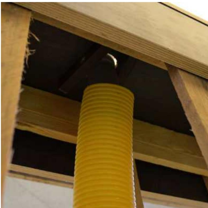
Im oberen Teil werden sie nur lose über das herausstehende Stück der HT-Rohre gesteckt.
